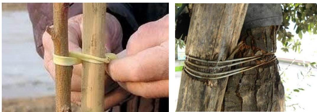
A sinistra, corretto uso di materiale per legatura dei pali al fusto. A destra danni dall'utilizzo di filo di ferro.
